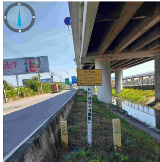
เครื่องหมาย และป้ายเตือนระบบท่อดึงน้ำบริเวณถนน
